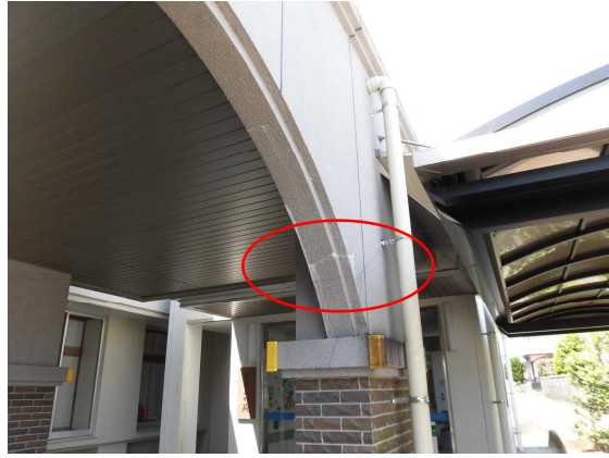
壁タイルのひび割れ
