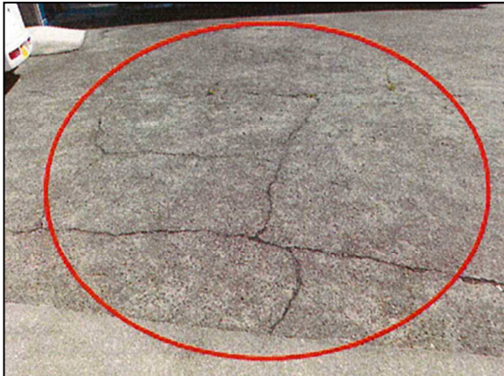
敷地舗装の状況
