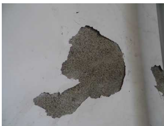
多目的ホールの壁の塗装の状況
