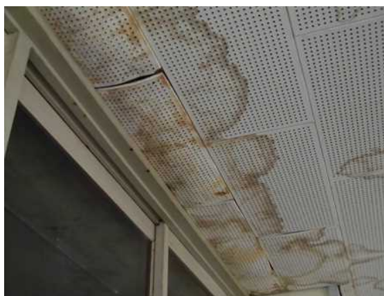
多目的ホールの天井の状況
