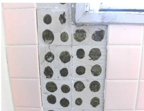
多目的ホールの壁タイルの状況
