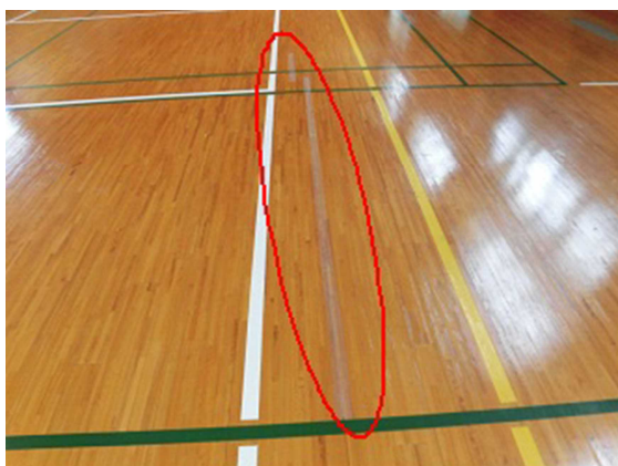
ホール床のテープ補修状況
