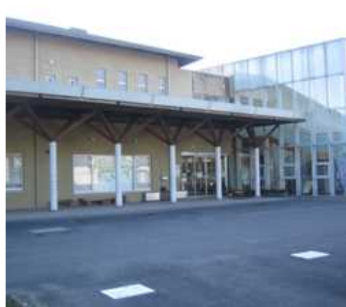
正面出入口付近
