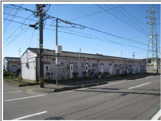
団地北側幹線道路沿いの景観(東から西に向けて撮影)
