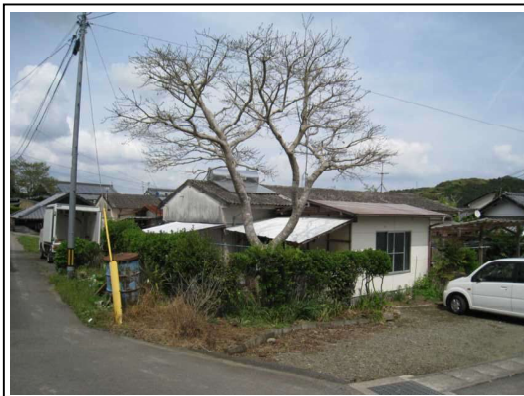
簡平住棟(1号棟)
