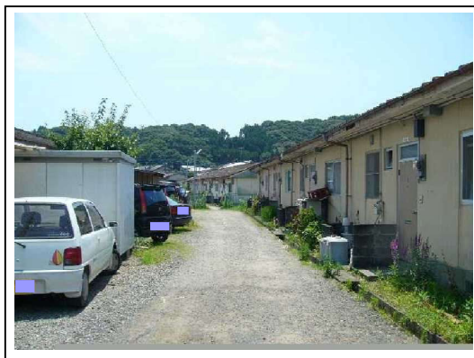
団地北側の簡平ブロック(奥は新町団地)
