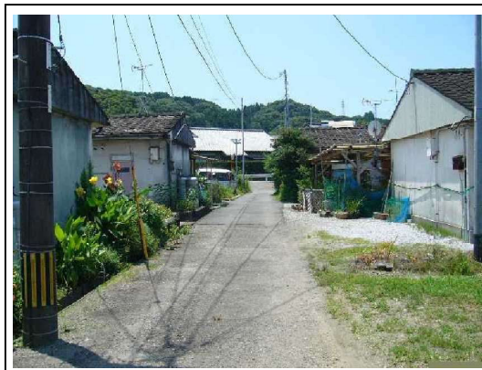
団地内道路の状況(右:43-5号棟)
