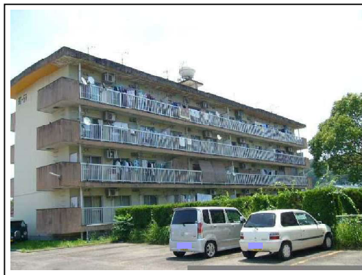
中耐住棟南側立面
