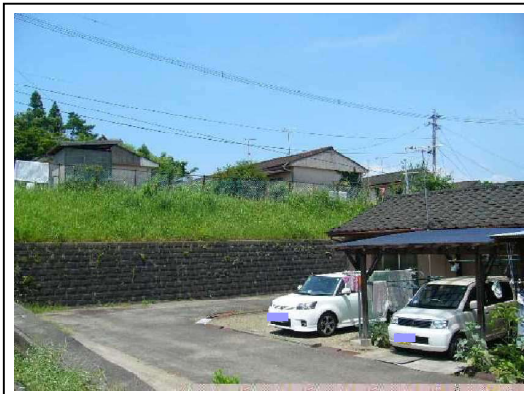
団地内高低差(手前:45-2号棟)
