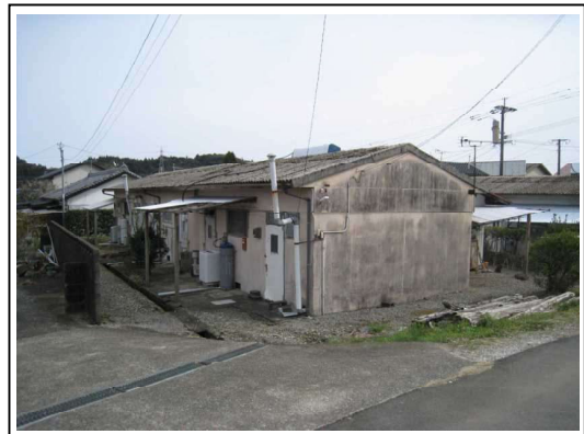
簡平住棟(2号棟)
