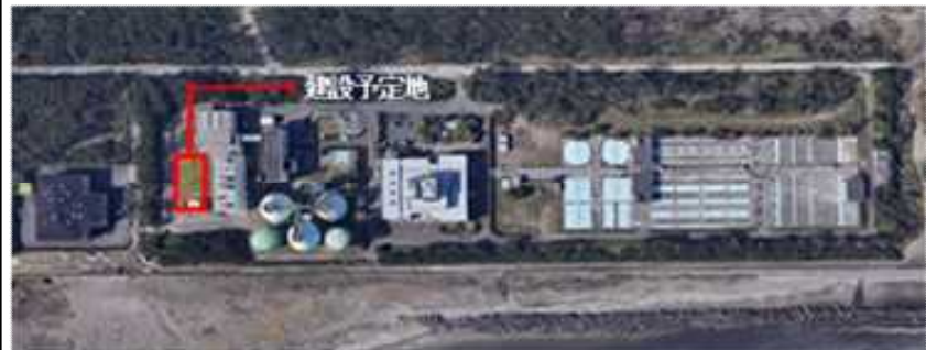
（焼却炉代替施設の建設予定地）
