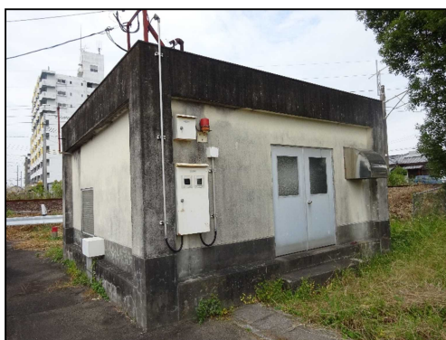
躯体 (恒久源藤ポンプ場)
