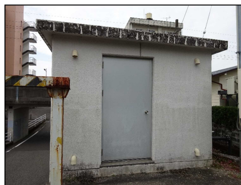
躯体 (神宮ポンプ場)
