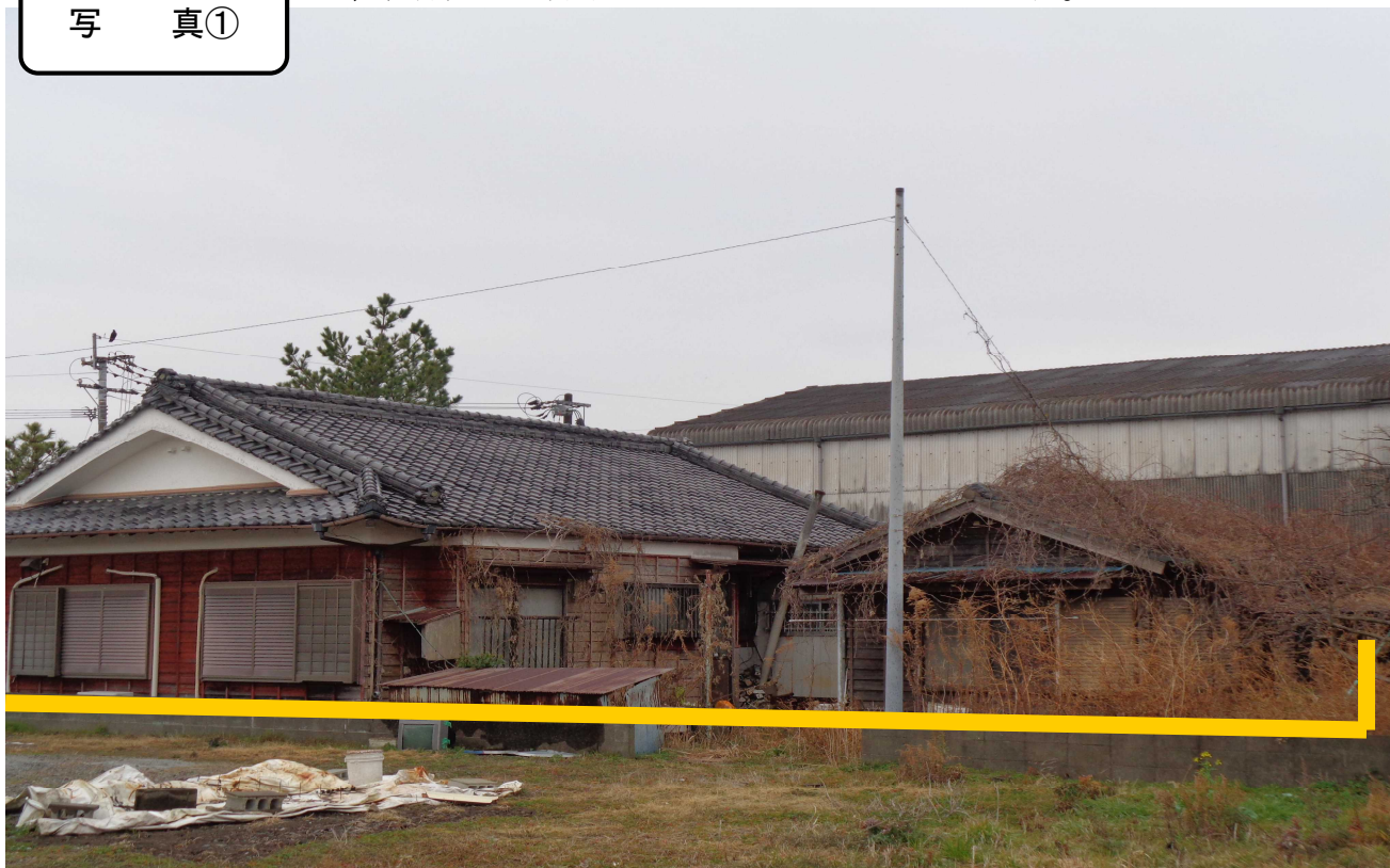
① 北東方より
