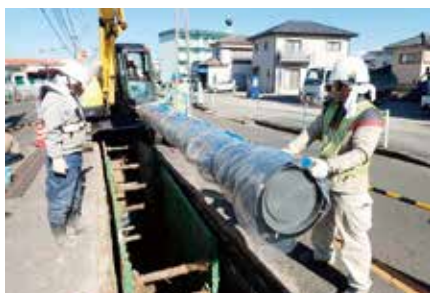
地震に強い水道管への入替作業
