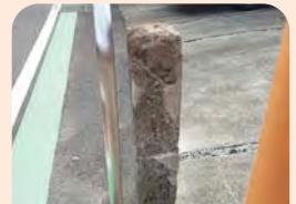
修復した道標(下北方)
