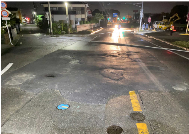
埋め戻し完了
