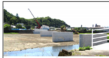
↑ 新町橋の橋脚が完成
