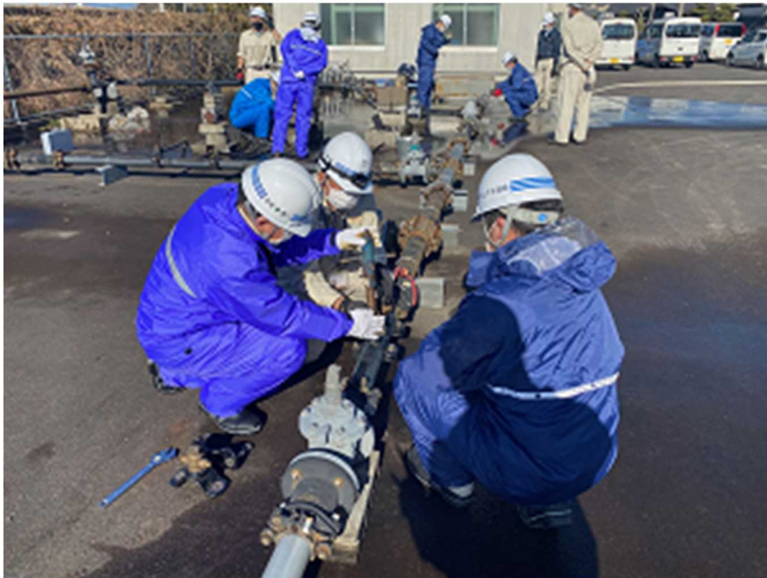
【管穿孔実技研修(1月11日・12日実施)】
