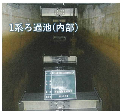
R4実施耐震補強の様子
