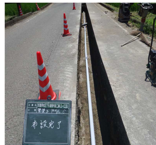
【田野町仮屋原地区の公共下水道接続工事】
