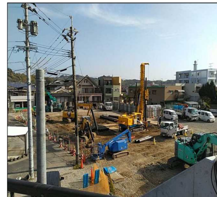
雨水ポンプ場整備状況
