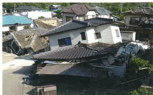
地震による被害例（熊本地震）
