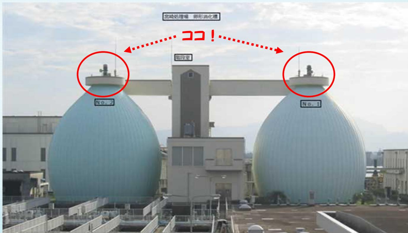
★下水処理の過程で発生した汚泥を混ぜ合わせることで有機物を分解し、ガスを発生させるための施設。
