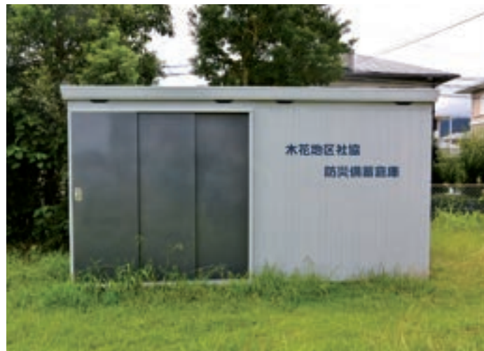
木花地区社協防災備蓄倉庫。
