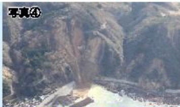
国道249号法面崩落
