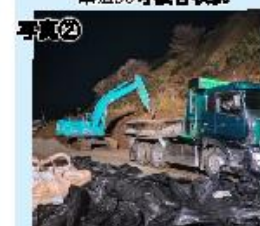
国道249号作業状況
