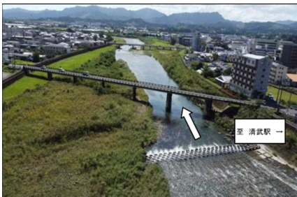
以前の新町橋
