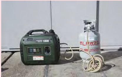
ガス発電機実演
