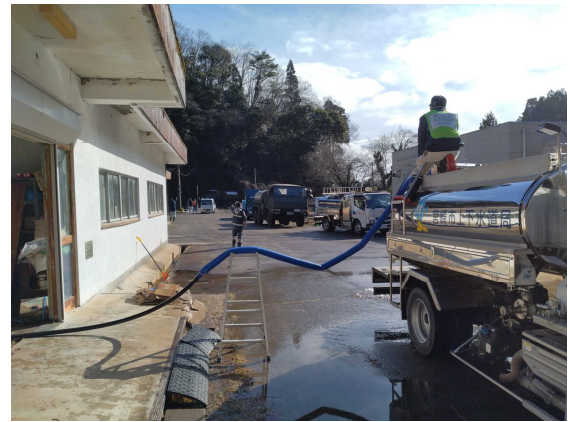
矢波浄水場での補水作業
