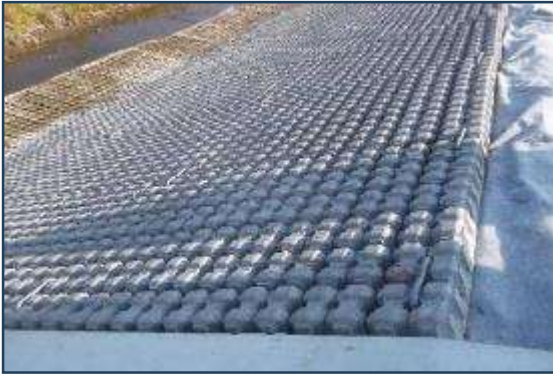
ブロックマット布設完了状況
