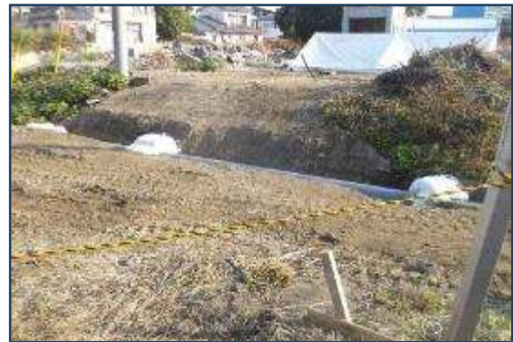
仮設パイプ設置状況
