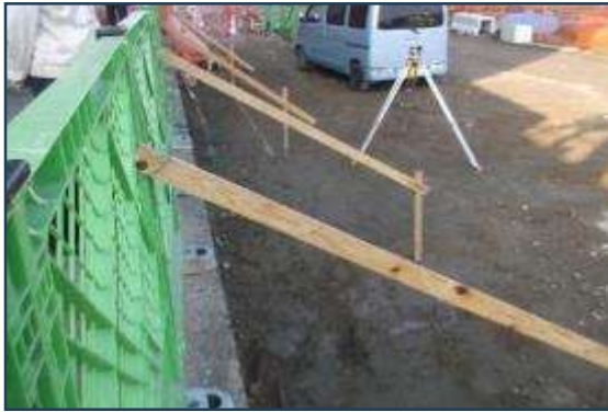
歩道安全柵固定状況
