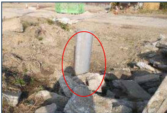
簡易井戸のパイプ
