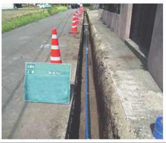
地震・災害に強い水道管を入れています
