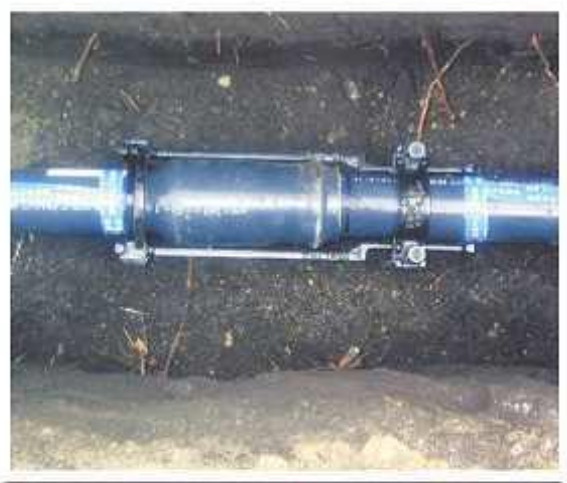
地震・災害に強い水道管を入れています
