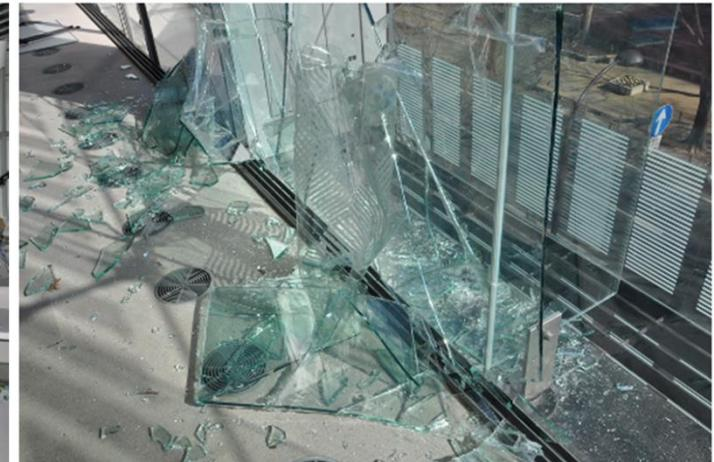
震災当日の外壁ガラスのようす(外壁の損傷)
