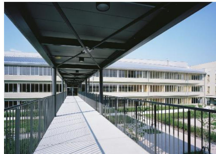
2 階レベルの接続通路
