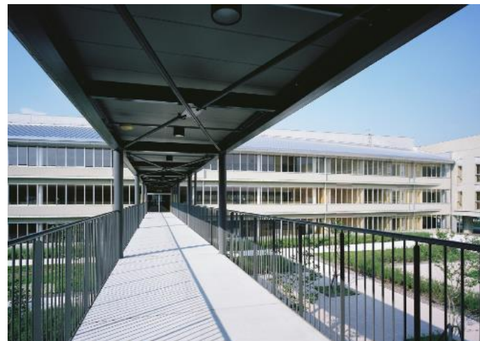
2 階レベルの接続通路
