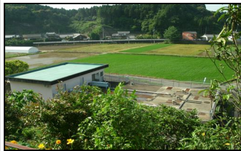
No.4068 ニュータウン祇園台 団地汚水処理施設
