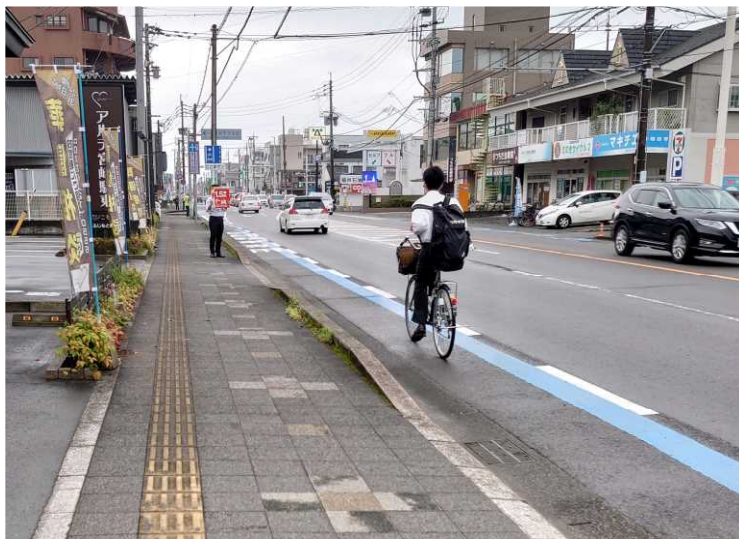
▲自転車通行空間（専用レーン）整備後の状況
