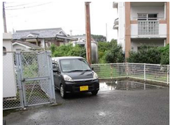
敷地内駐車場の水捌け不足
