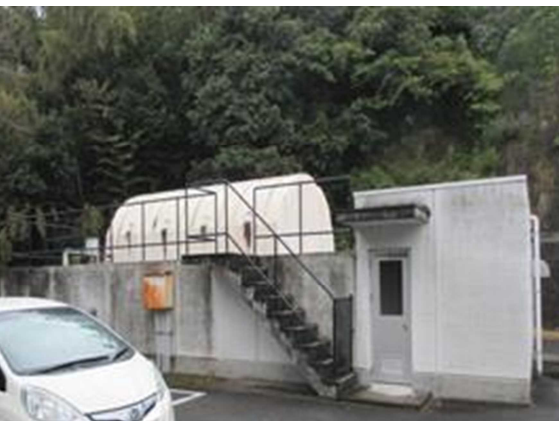
排水処理施設（回転円板）の老朽化
