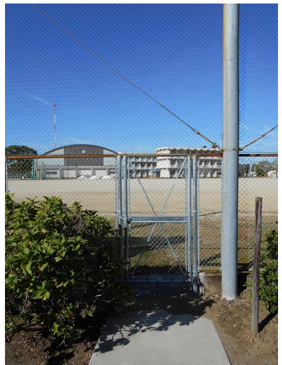
<R6.3.18 に新設された簡易扉>
