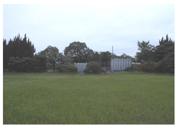
No.4007 旧鹿村野小学校
