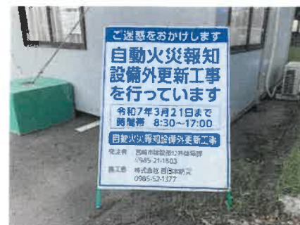
図Ⅱ-5 工事中を表示する看板
