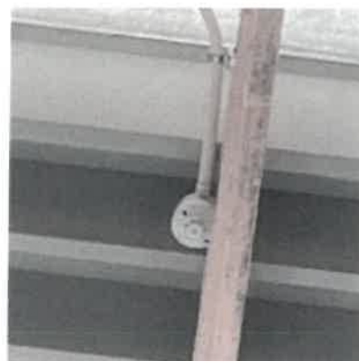
図Ⅱ-2 熱感知器の取付け
