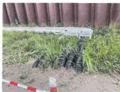
図Ⅲ-4 トラフから地下への入り口
