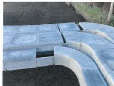
図Ⅲ-5 トラフの状況
