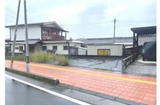
No.8 道路残地 (清武町木原)
