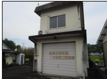
No.4041 消防団車庫
