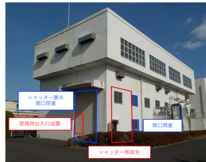
合流ポンプ棟耐震化工事（宮崎処理場）
