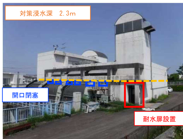
大谷雨水ポンプ場耐水化工事
