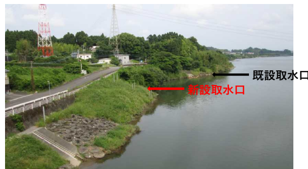
柏田水源地取水口
