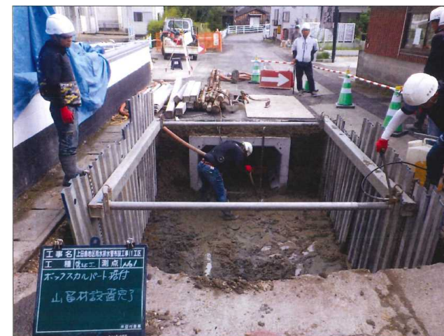
上田島地区（佐土原）排水路整備状況
