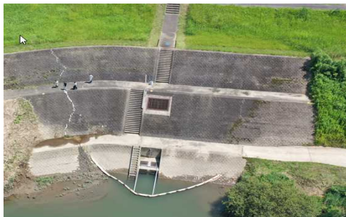
通常時取水口
