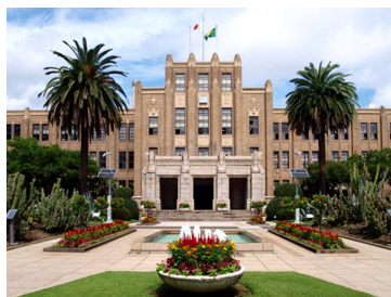
建築物(宮崎県庁本館)
