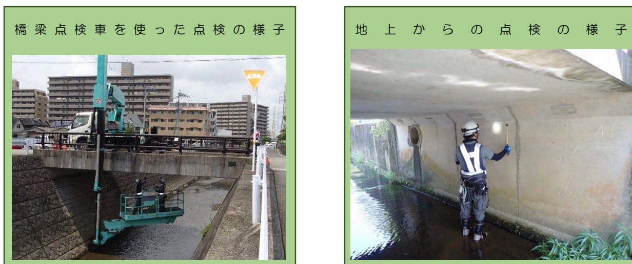
図 6 定期点検の様子
