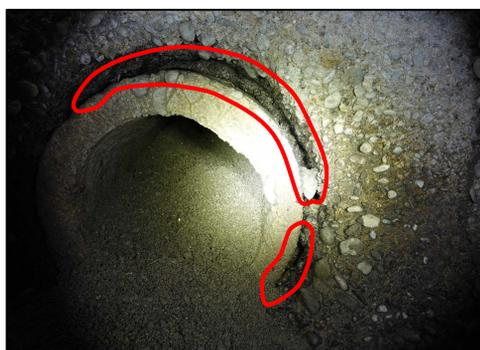
マンホールとの接続部に隙間(写真①)
