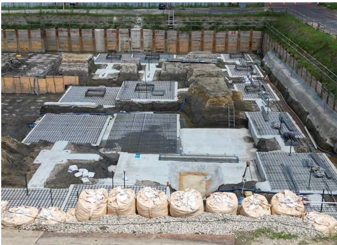
【基礎躯体工事施工状況】
