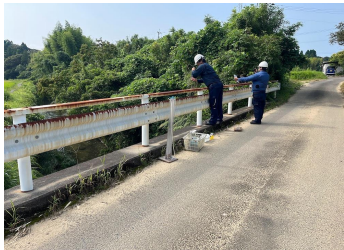
石崎川無名橋
