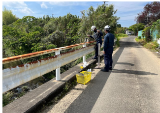
石崎川無名橋
