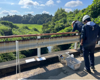
石崎川無名橋
