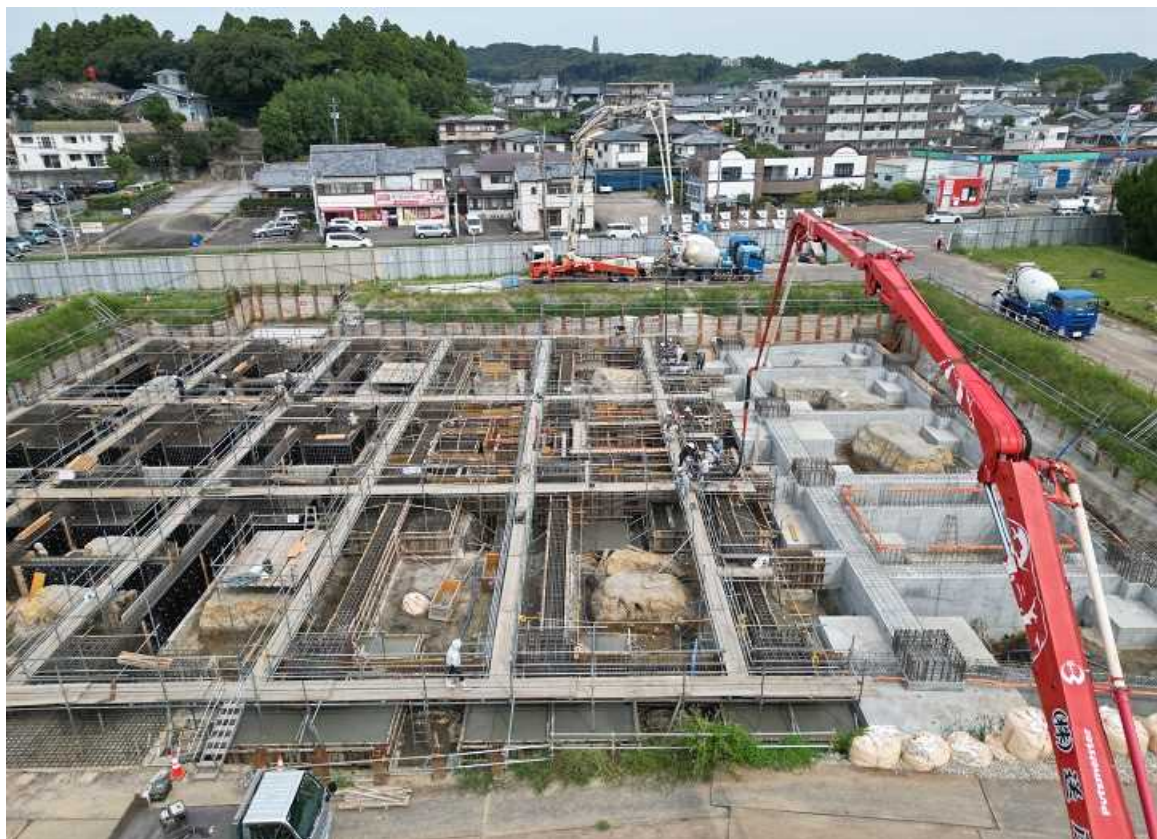
【基礎躯体工事施工状況】
