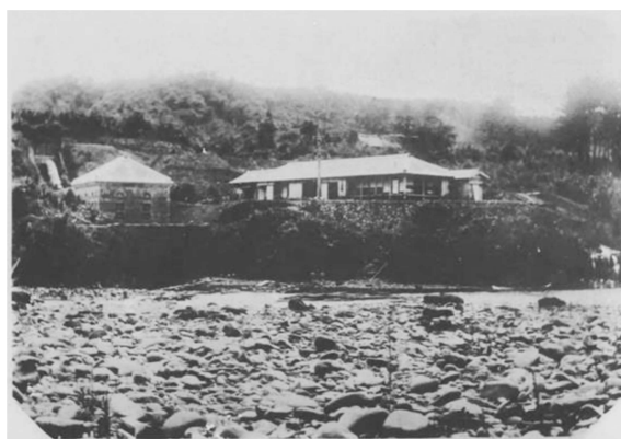
操業から間もない黒北発電所（宮崎縣大観より転載）
