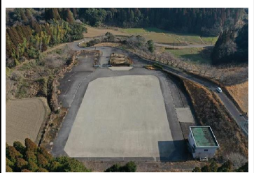
No.4069 内之八重処理場跡地外
