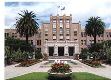
建築物（県庁本館）
