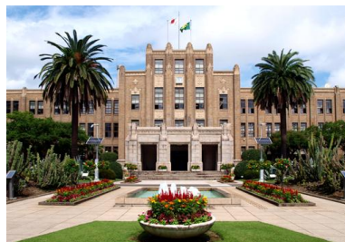
建築物(宮崎県庁本館)
