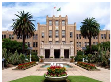
建築物(宮崎県庁本館)
