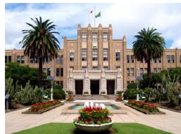
建築物（県庁本館）
