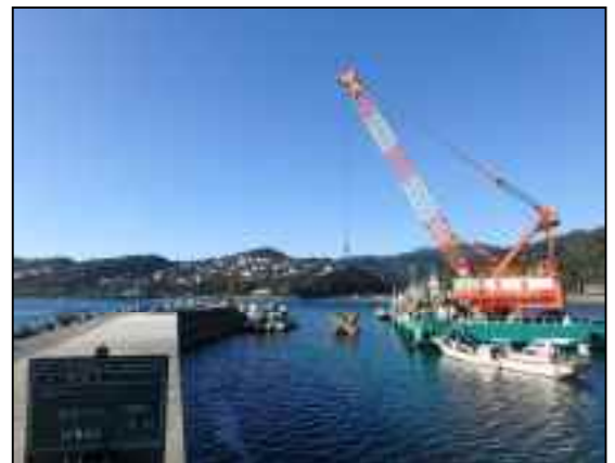
消波ブロックの据付
